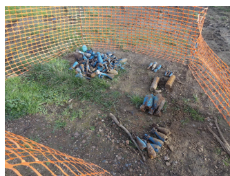
Dépollution du Groupe 2 (crédit photo : Urbasolar)
